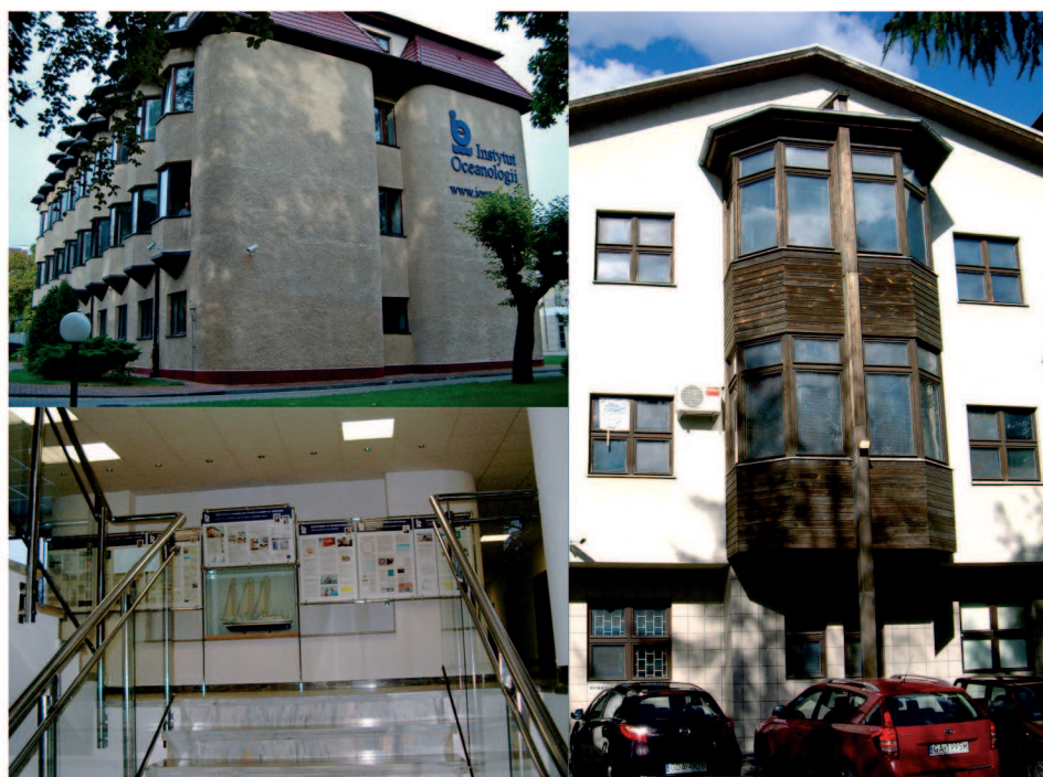
Fot. 3.8. Rozbudowa infrastruktury Instytutu
