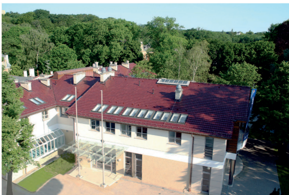
Fot. 1.45. Widok nowego, trzeciego segmentu zabudowań Instytutu Oceanologii PAN, o powierzchni użytkowej 2500 m kw., oddanego do eksploatacji w 2007 r.
