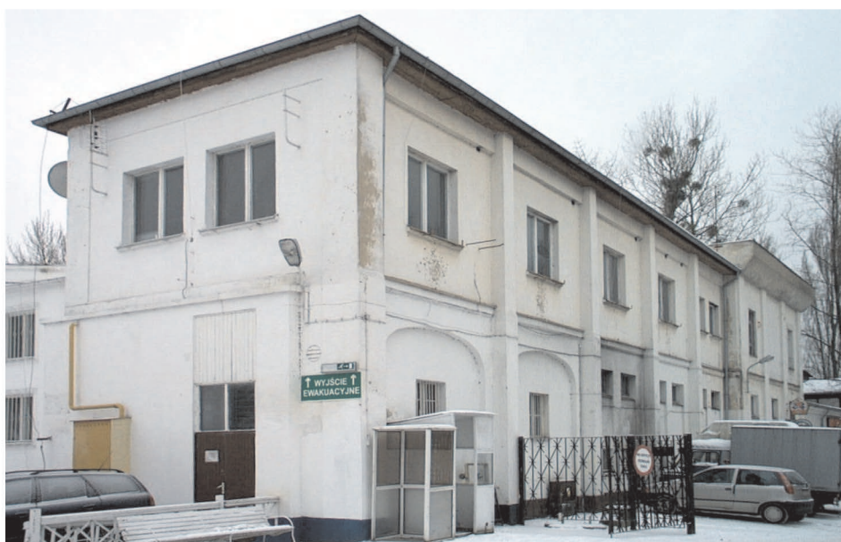
Fot. 1.3. Budynek Stacji Morskiej PAN w Sopocie, przy ul. Powstańców Warszawy 2-4-6, działającej od 1953 r. do 1993 r., w ostatnich latach już jako część Instytutu Oceanologii PAN. Zburzono ten budynek w 2007 r., a teren pod nim wykorzystano pod budowę nowego Domu Zdrojowego (reprodukcja z książki Dery (2010))
